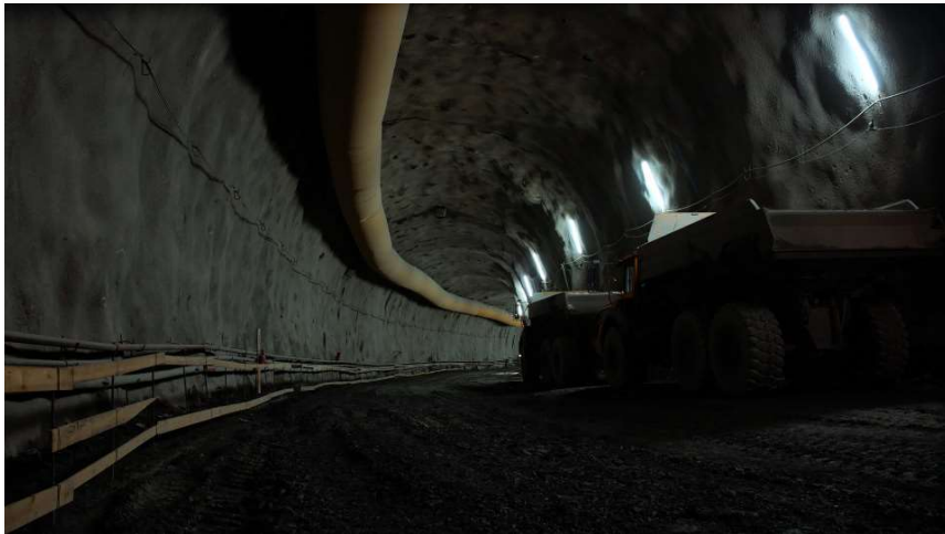
Bau des Küchelbergtunnels: Millionenprojekt in trockenen Tüchern.
